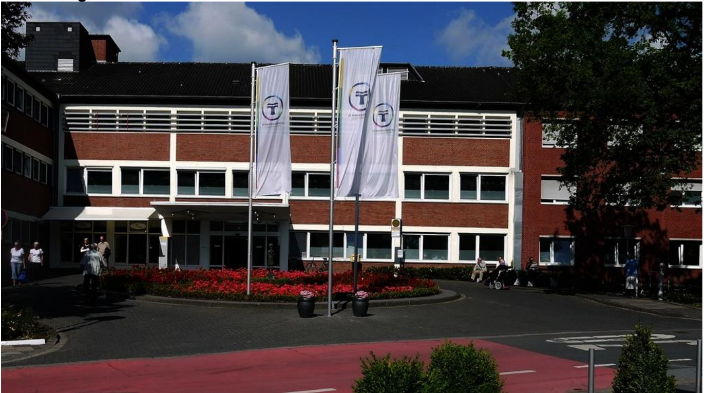
Abbildung: Ansicht des Haupteinganges des St. Marien-Hospitals Lüdinghausen
