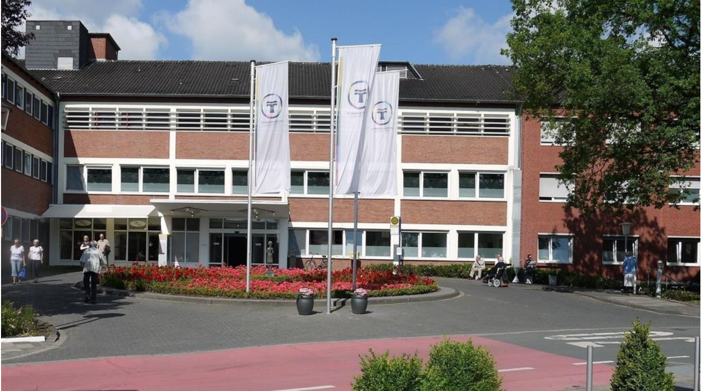
Abbildung: Haupteingang St. Marien-Hospital Lüdinghausen
